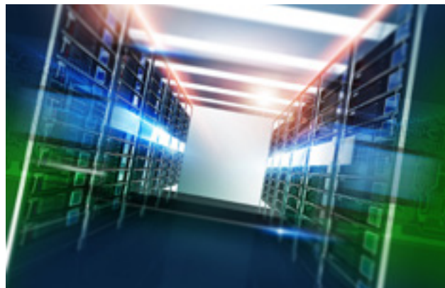
Kolokacja to przekazanie firmie zewnętrznej serwerów do dedykowanych do tego celu pomieszczeń
